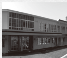
平成23年2月に合築 藤波園正面玄関 (藤美寮と併設)
